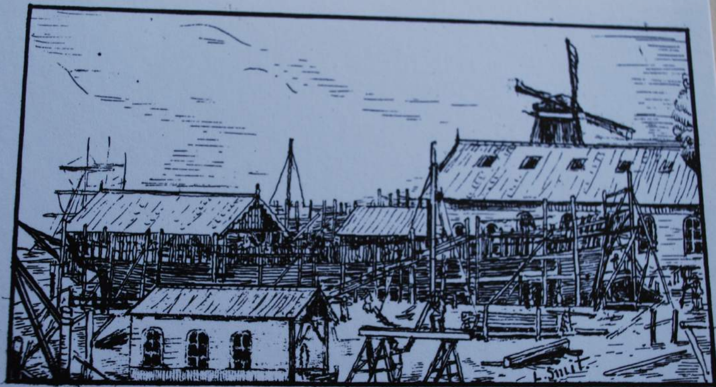
Bark „Eersteling“ in aanbouw. werf J.K. Smit 1847-48 eerste schip. door J.K. Smit Kinderdijk - eerste schip voor M. Lels. - op stapel in de haven. die is. afgedamd en drooggelegd -
