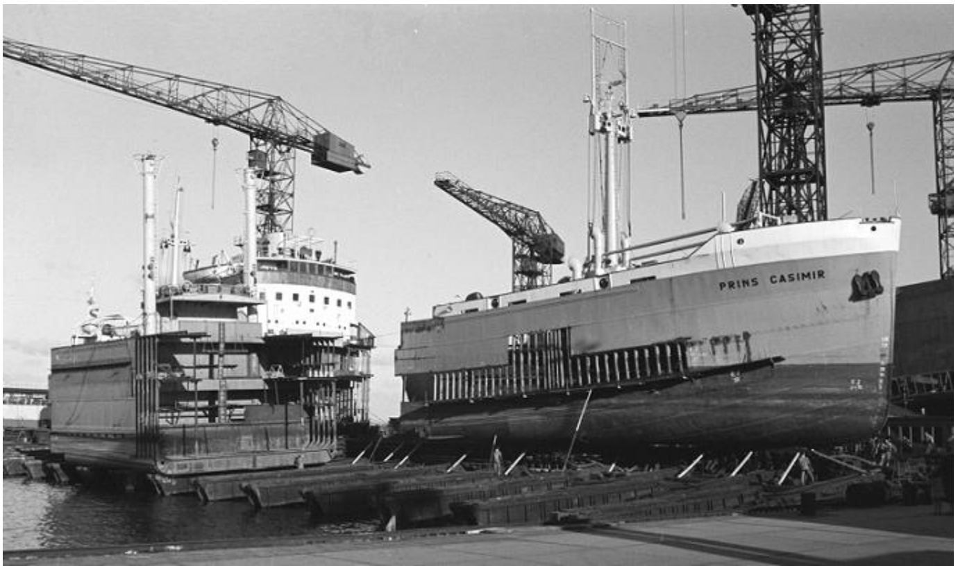
M.s. PRINS CASIMIR van de rederij Oranje Lijn op de scheepshelling van Boele Bolnes om met een tussenstuk verlengd te worden. Foto: Ary Groeneveld # 3880, 11-01-1960 Gemeente Rotterdam (Stadsarchief).
